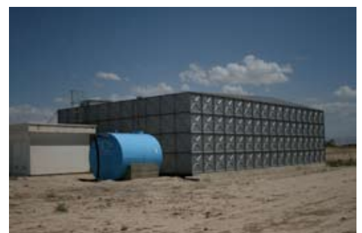
Neuer Wassertank in Kunduz.
